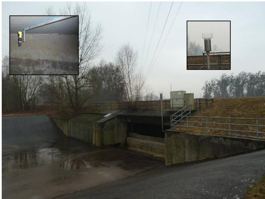
Abbildung 1: Mischwasserüberlaufbecken Plesching mit Höhenstands- und Niederschlagsmessung (Wendner, 2011)
