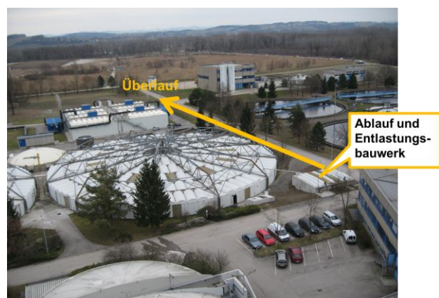
Abbildung 4: Zulauf- und Entlastungssituation auf der Kläranlage Linz-Asten
